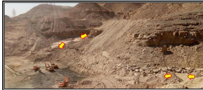
(صورة رقم ١٣) مسارات التصريف السطحية باتجاه موقع المحطة بشكل يشكل خطورة وتعرضها لخطر السيول
