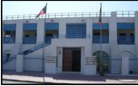
الشكل رقم (١) يوضح الواجهة الخارجية للمبنى بيت ديكسون مع عناصر البيت التراثي بالالوان الابيض والازرق الفاتح
