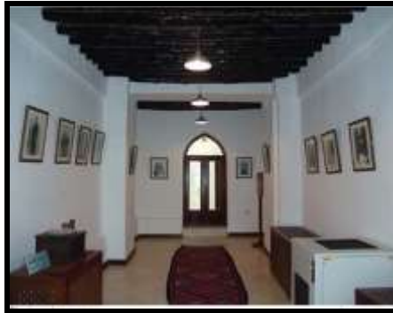
الشكل رقم (٣) يوضح احد الغرف بالمنزل مع استخدام خشب الشندل للسقف ( بيت ديكسون )
