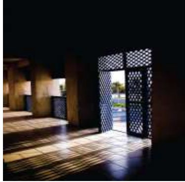
شكل رقم (٦) يوضح فكرة المشريبات للسماح للضوء والهواء ومنها المحافظة على التصميم التقليدي
