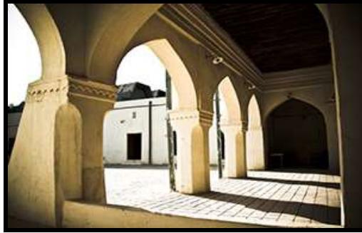
الشكل رقم (١١) يوضح اللبوان وكما يوضع الغقود بالشكل الاسلامي البسيط مع عملية التكرار في التنفيذ
