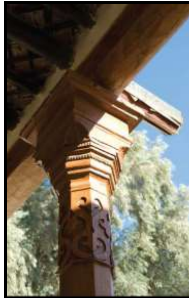
كما هو في الشكل رقم (١٦ أ ، ب ) يوضح الطراز المستخدم بالأخشاب الهندية المستوردة مع التفاصيل الزخرفية المستخدمة في الناج للعمود
