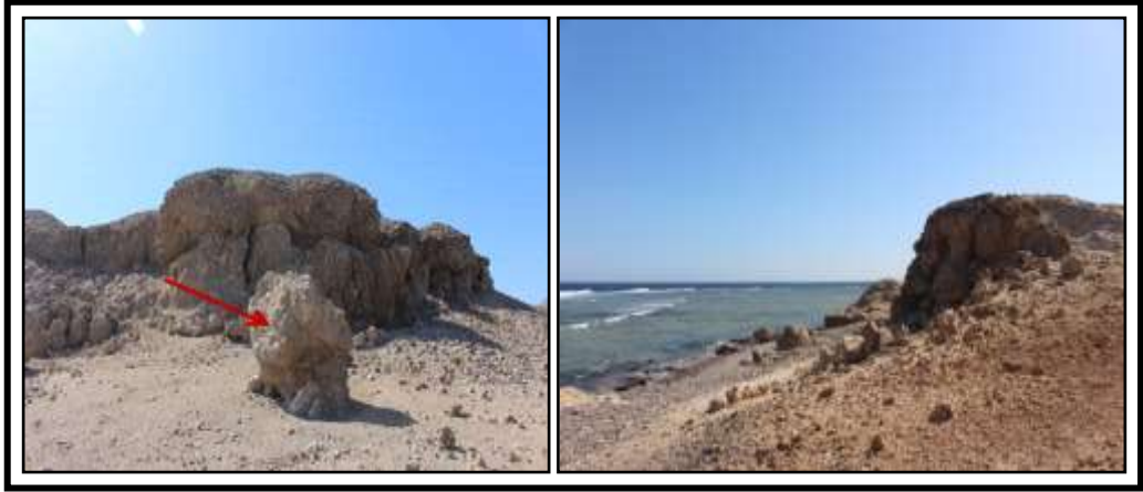
صورة (٢) الكتل الصخرية المتساقطة من واجهة الجرف البحري
